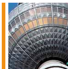
Fernsehturm Телебашня Television Tower
